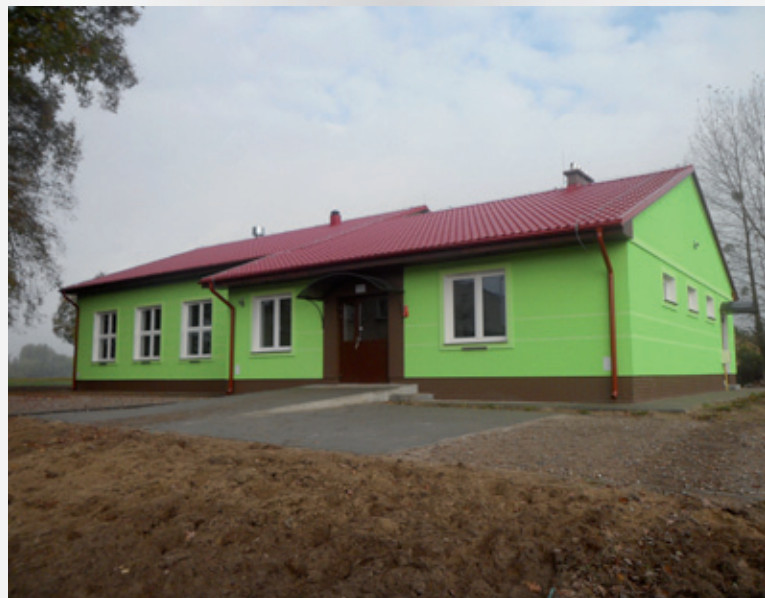
Świetlica wiejska w Lutolu Mokrym
