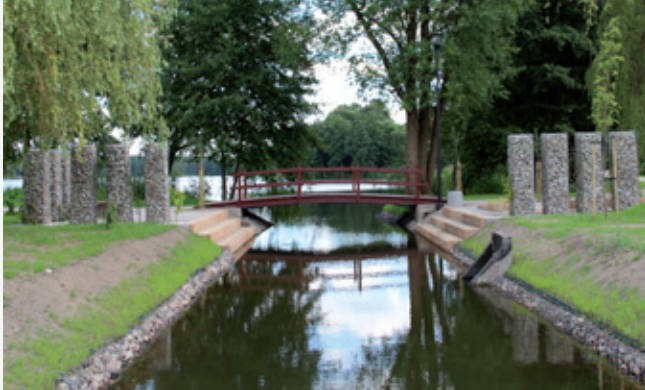
Bulwar w Przytocznej
