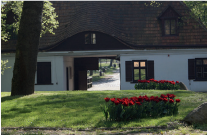
Budynek bramny kompleksu muzealnego w Międzyrzeczu
