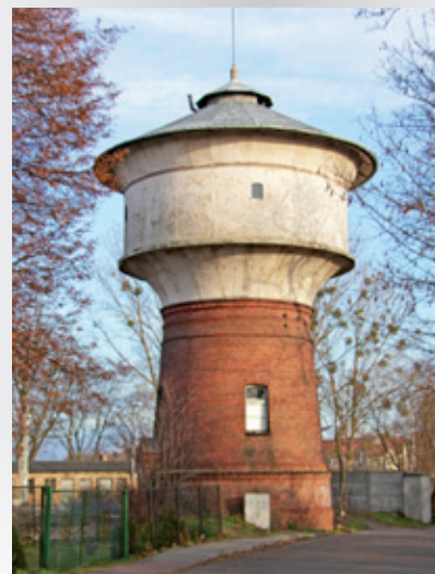
Kolejowa wieża ciśnieniowa ze zbiornikiem typu INTZE w Międzyrzeczu
