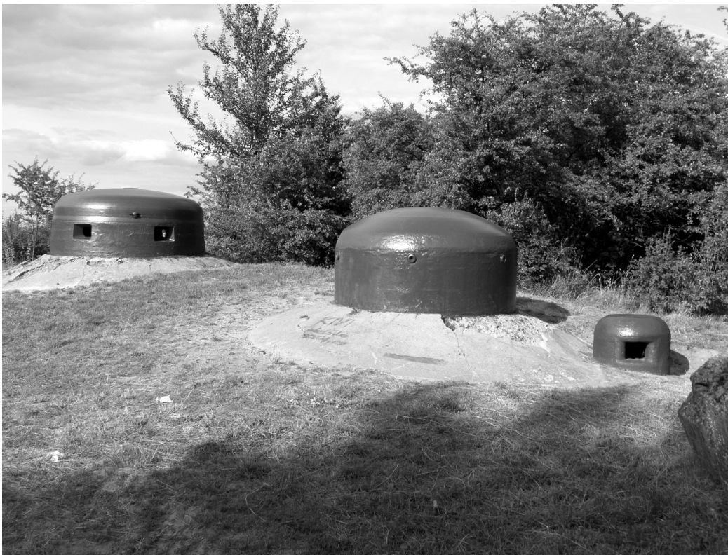
Ilustr. 17 Kopuły na obiekcie PzW. 724 w okolicach Nietoperka. Stan z 2010 roku, fotografia autora
