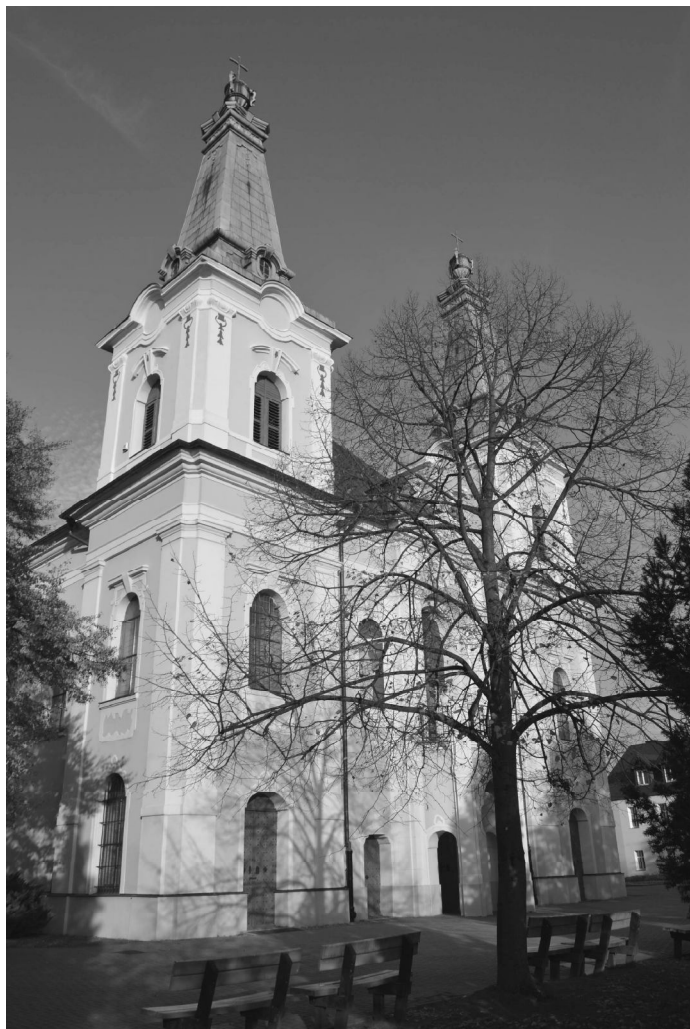
Ilustr. 8 Zachodnia fasada kościoła w Rokitnie oraz wieże - dzwonnice. Widok współczesny, fotografia autora
