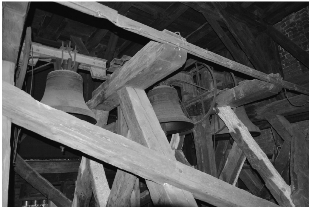
Ilustr. 24 Dzwony i koleba przed konserwacją w kościele pw. Świętego Jana Chrzciciela w Międzyrzeczu. Fotografia autora z 2015 roku
