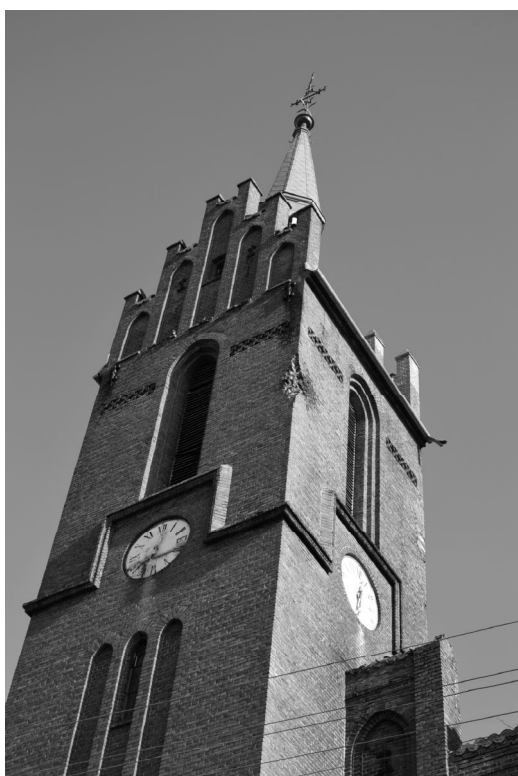
Ilustr. 5 Fragment wieży · dzwonnicy kościoła farnego w Bledzewie z widocznym uszkodzeniem po pocisku artyleryjskim. Widok współczesny, fotografia autora
